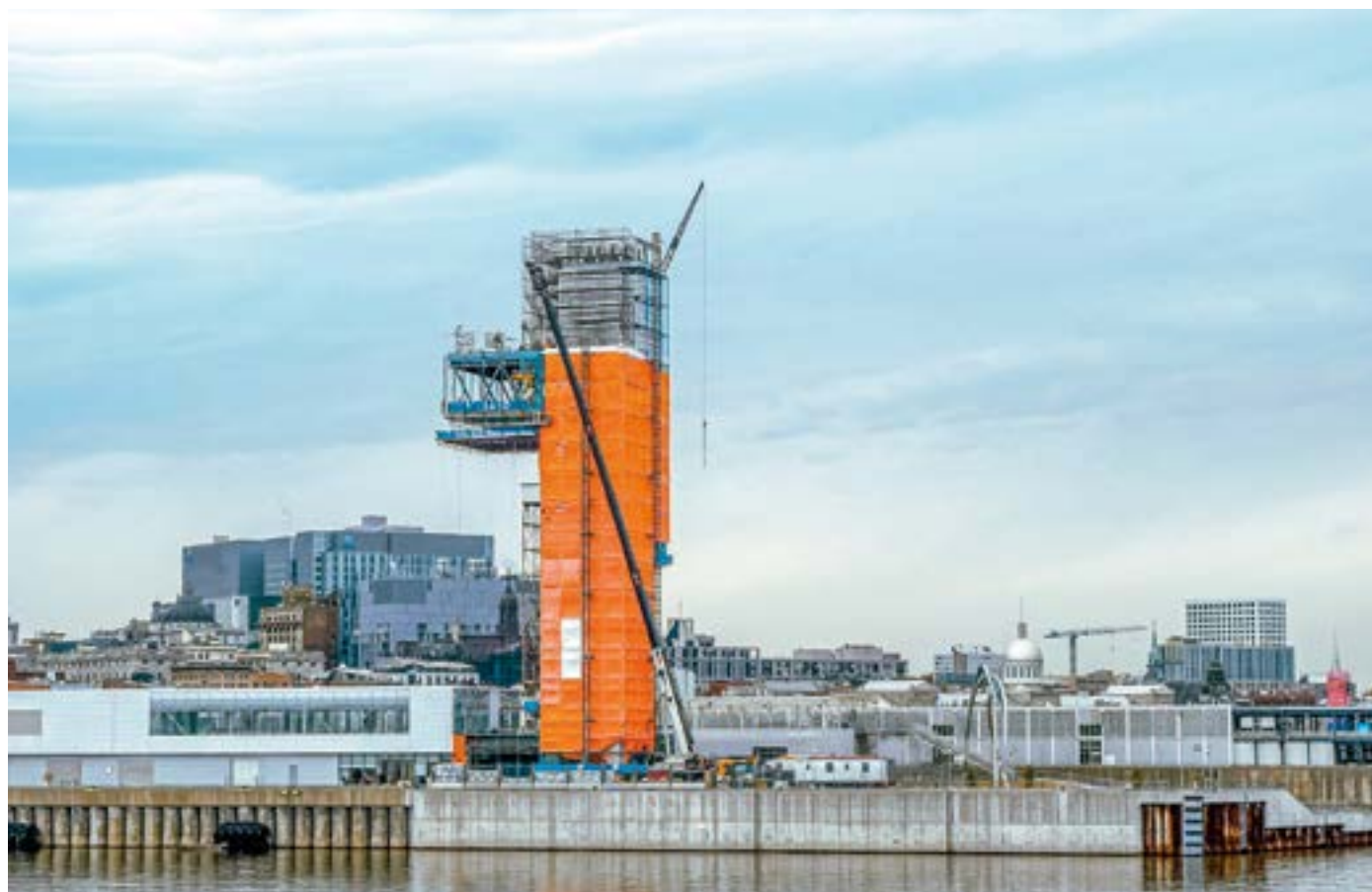
Pose de vitres par Heavydrive sur la Tour du Grand Quai du Port de Montréal au Québec (Canada)
