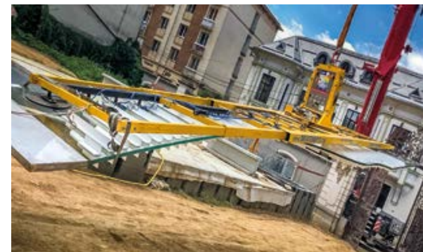
L'installation Heavydrive transporte les vitres ondulées de 12,5 m de haut. Droits d'image : montec-gmbh.de
