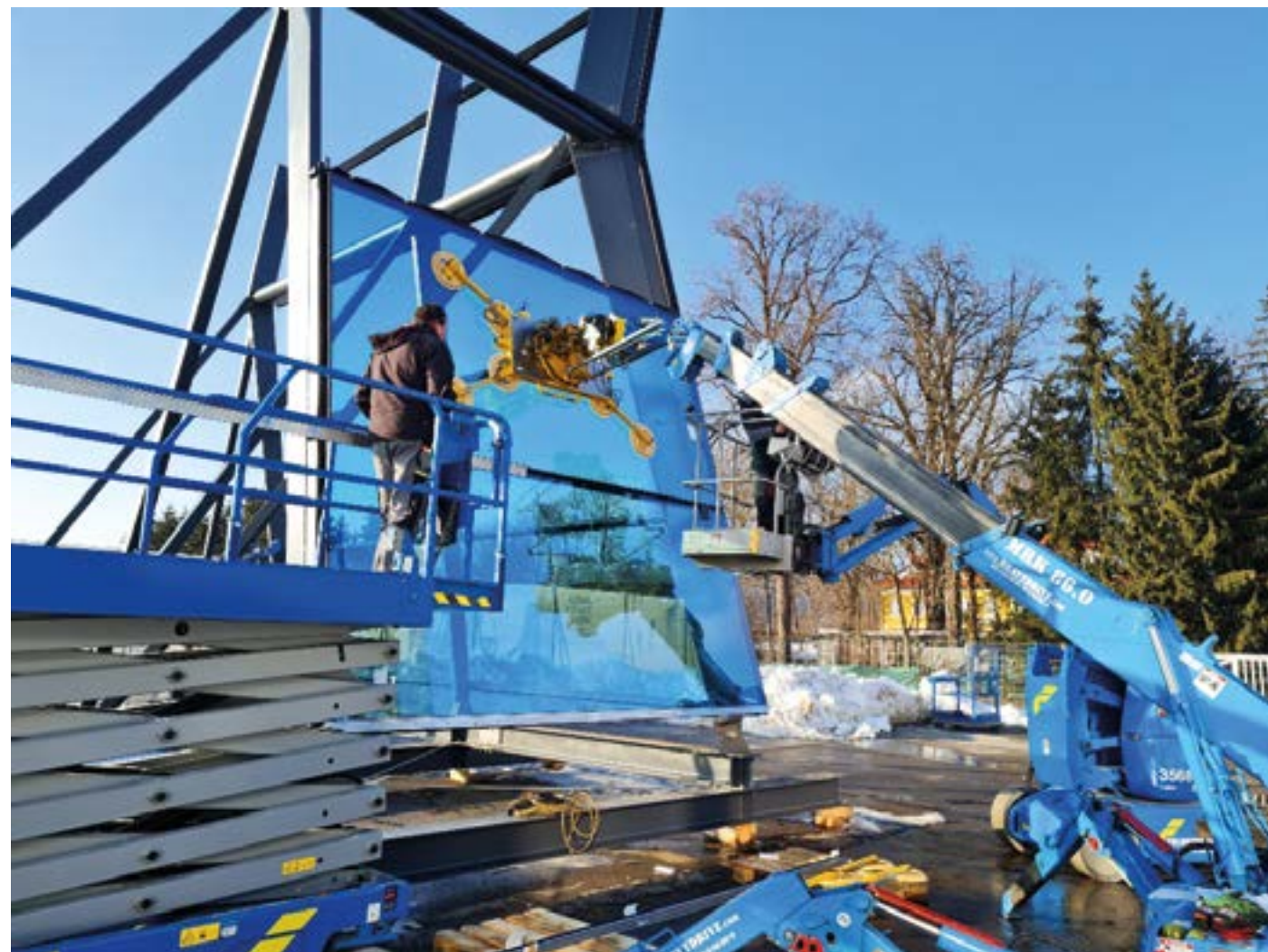
L'intervention test de Heavydrive avec le MRK 86.0 et le manipulateur pour manutention aérienne VSGU 800 K
