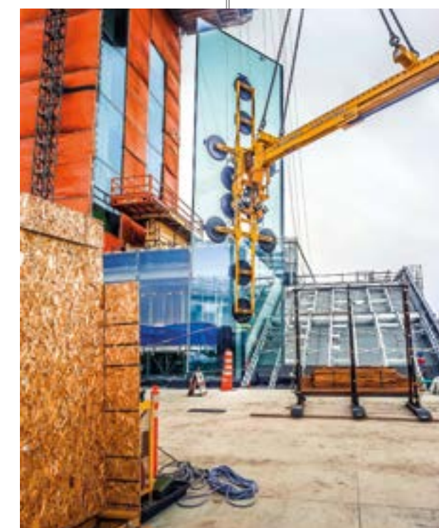
Montage à une hauteur de 60 mètres avec VSG 3000 KMH et VSG 2000 Konter
