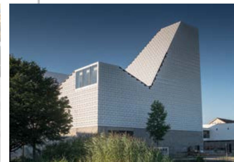
Ces baies vitrées ne sont accessibles que du côté du parc
