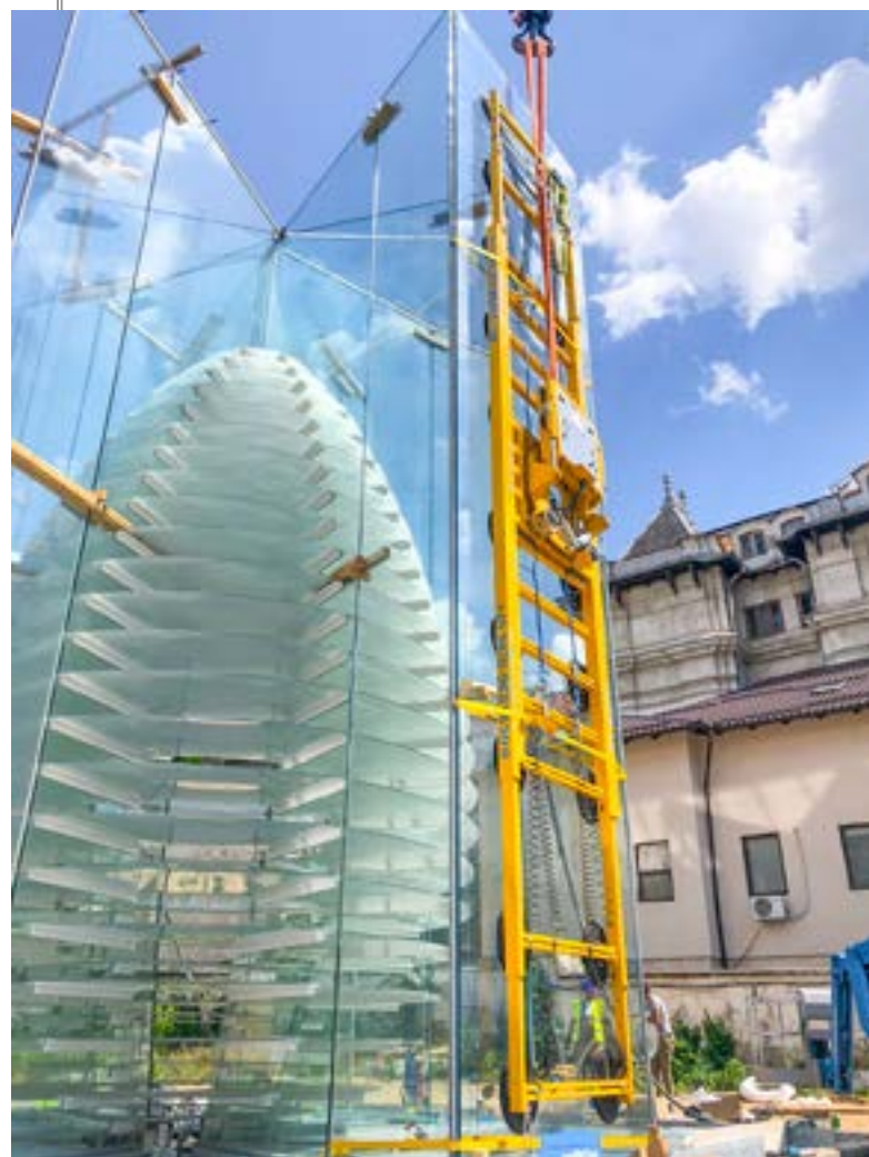
Pose de vitres avec le VSG 4000 KM H dans le pavillon Brancusi du Musée d'art de Craiova (Roumanie) Droits d'image : montec-gmbh.de
