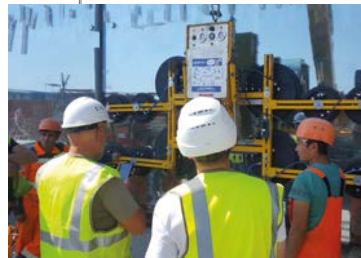
Instruction sur le site : système à ventouses VSG 1500 KH
