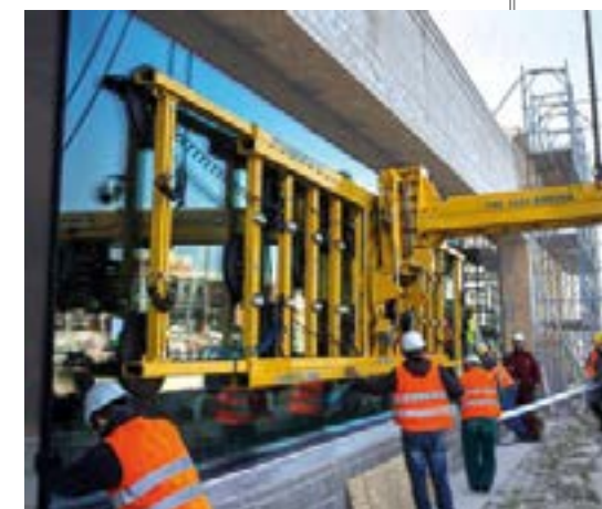
Montage de la vitre de 4 tonnes
